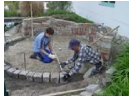
Die Kreisfläche wird eingebnet. Die Kreissteine werden gesetzt. Der Fugenmörtel wird angerührt.
