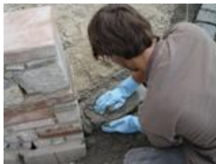
Schüler lernen, wie lose Steine verfugt werden, auch fachgerechte Arbeitskleidung (Handschuhe) ist bei dieser Tätigkeit unbedingt erforderlich.
