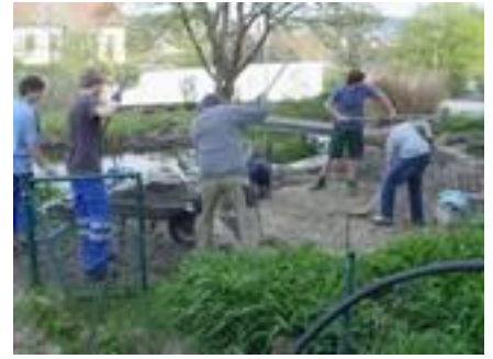
Die Arbeiter nivellieren den Steinkreis.
