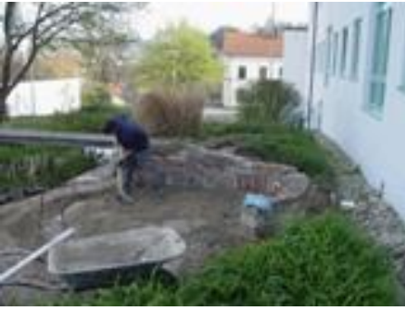
Der Innenbereich wird eingebnet.
