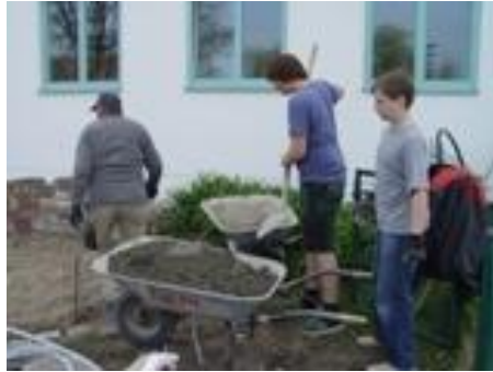
Fundamentbeton wird für die Katzenköpfe ausgebracht.
